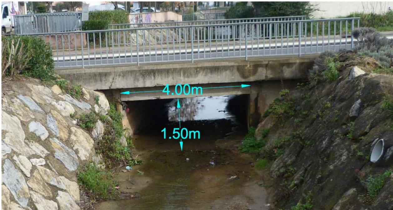
Figure 11 : Ouvrage hydraulique amont existant
