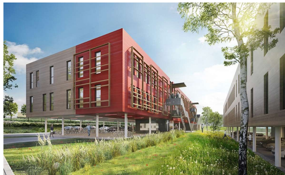
Le Havre, ZAC du Pressoir, bureaux (Richez arch.)
